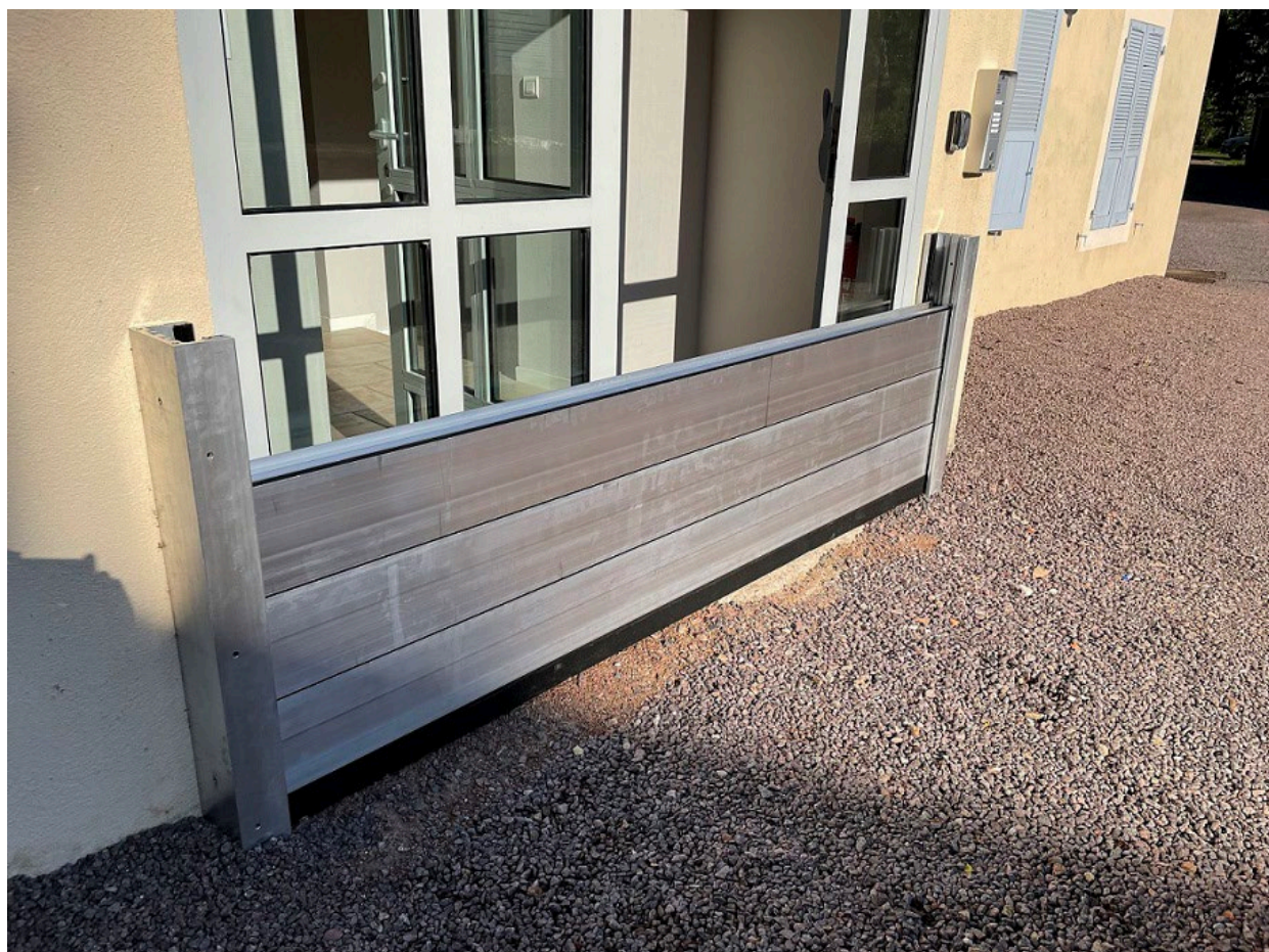
Pose d'un batardeau devant l'entrée d'un immeuble à Semur-en-Auxois (Yonne) © Even du fou (syndic de copropriété) 2022
