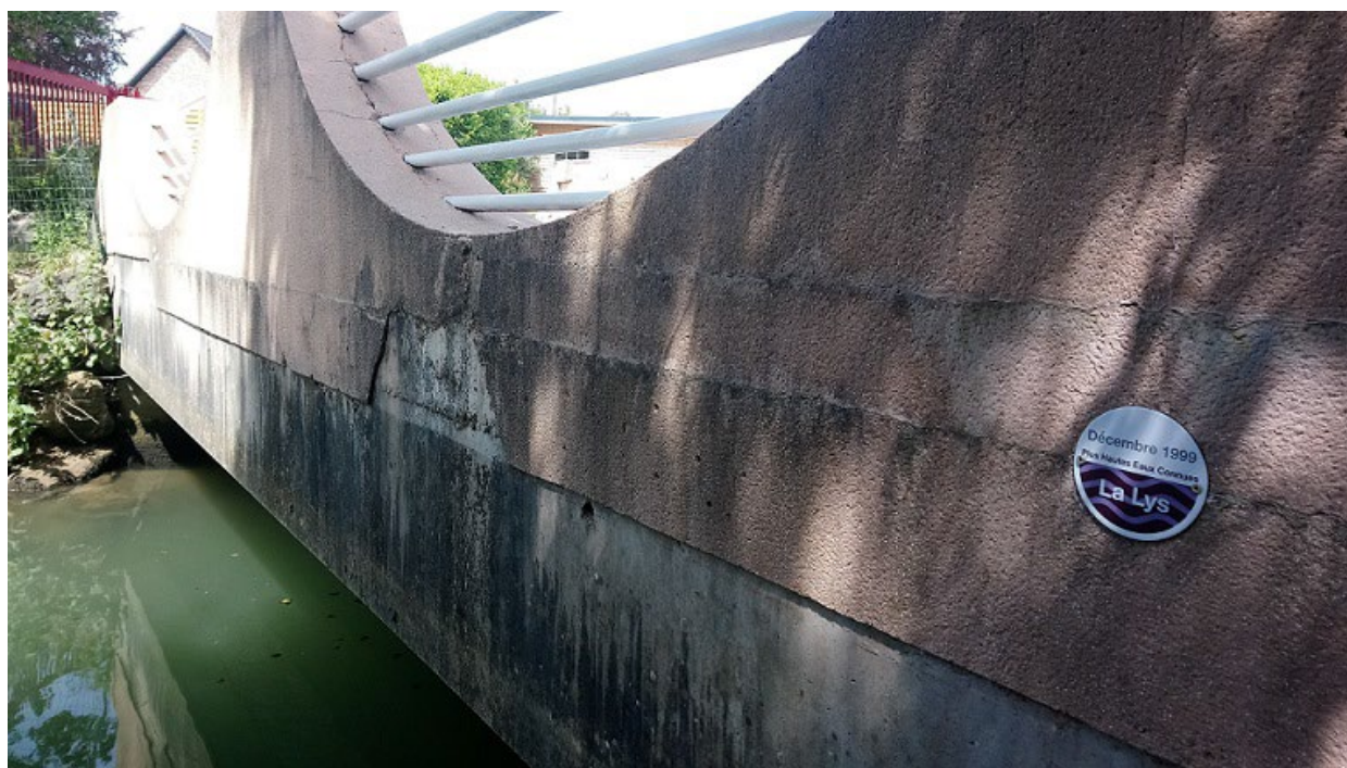
Repère de crue posé à Dennenroeuq (Pas-de-Calais) © SYMSAGEL, 2020
